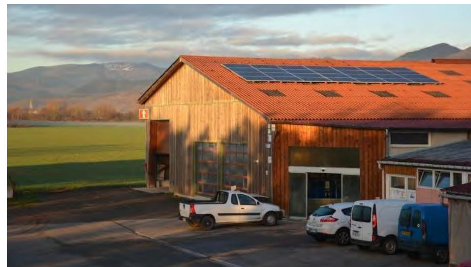
Panneaux photovoltaïques sur une ferme dans les Vosges
