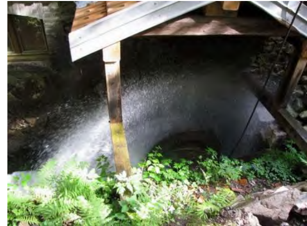
Turbine hydraulique pour une scierie dans les Vosges
